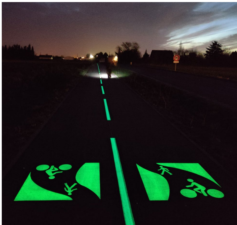
Peinture routière photoluminescente LuminoKrom®
